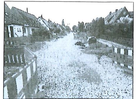
*Bodenfeldstraße: Die warmen Temperaturen erschweren den Einbau der neuen Trinkwasser-Versorgungsleitungen. Nachdem sie bereits im Juni verlegt worden sind, mussten die Leitungen mehrfach desinfiziert, gespült und beprobt werden.*
