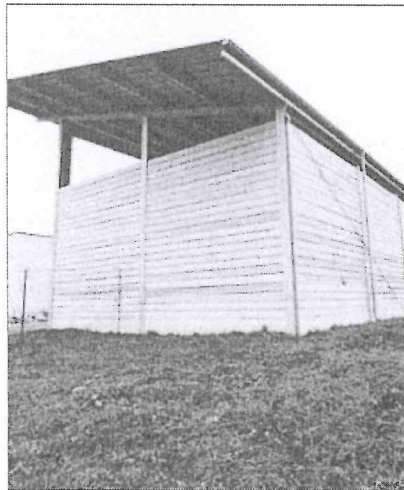
Das Lager am Biomasseheizwerk ist betriebsfertig. Foto: Simone Schinnerer
